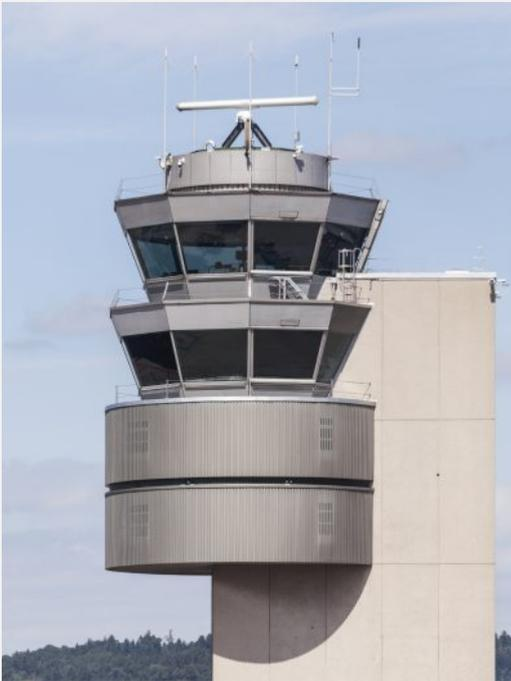
Foto 1: Auf zwei Ebenen sorgen Folienrollos im Tower Zürich für zuverlässigen Blendschutz
