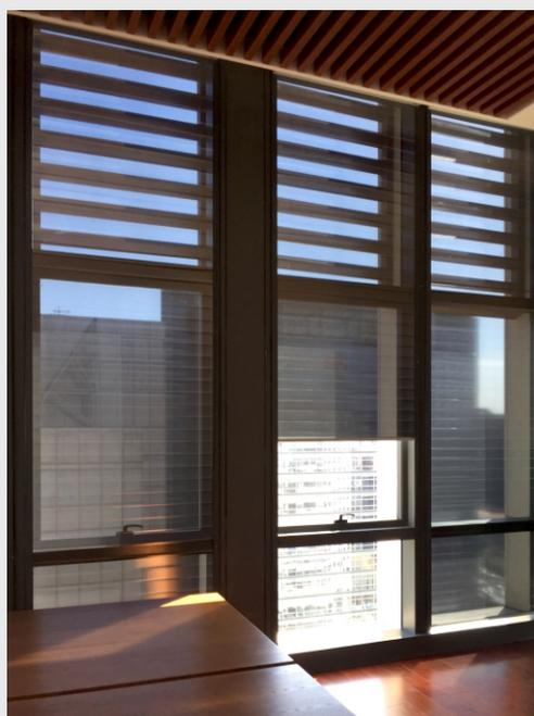
Foto 3: MULTIFILM®-Folienrollos gewähren Blendschutz und freien Blick nach draußen
