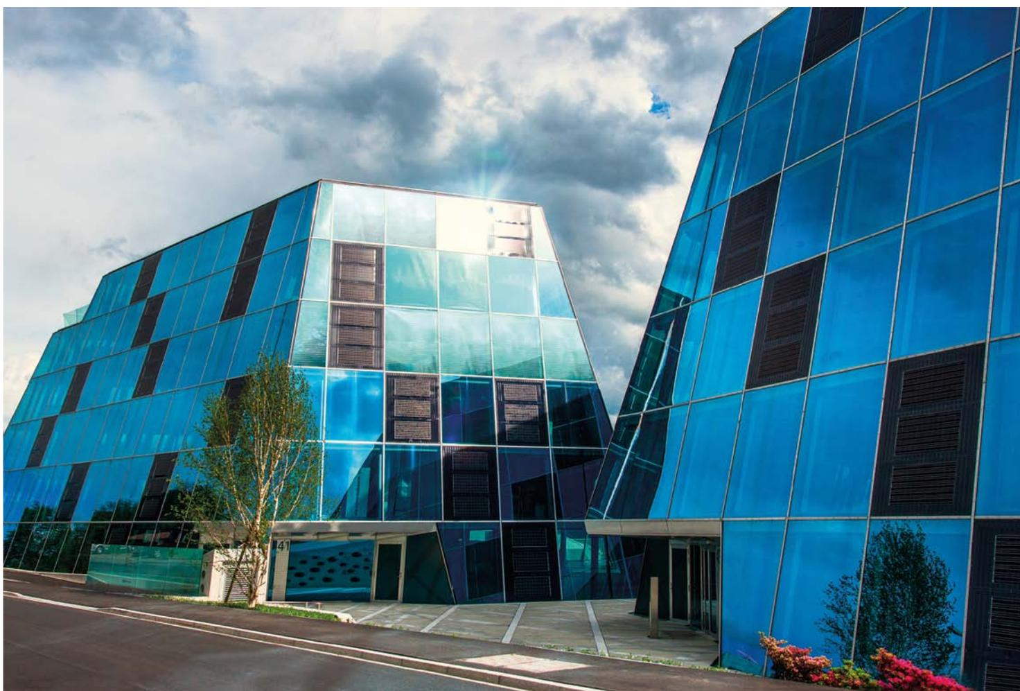
**Sunreflex hat zwei pyramidenförmige Bürogebäude in Wollerau mit einem innenliegenden Sonnenschutzsystem ausgestattet. Es bietet effizienten Schutz vor Hitze und Blendung und verbessert die Wärmedämmung im Winter um 25 Prozent. An den geneigten Glasfassaden mit Zweischeiben-Isolierverglasung montierte Sunreflex insgesamt 500 Gegenzuganlagen, davon 100 in Trapezform.**
