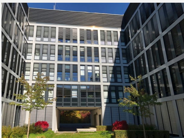
Foto 3: Innenliegenden Rollos sorgen auch bei Wind für zuverlässigen Blendschutz
