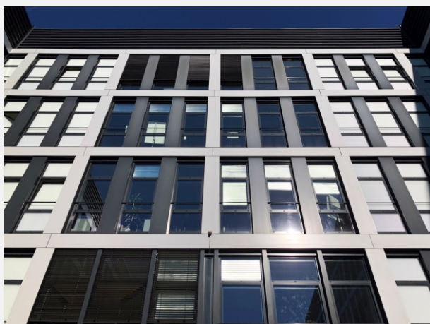
Foto 5: Der hochreflektierende Folienbehang schützt effektiv vor Sonnenstrahlung
