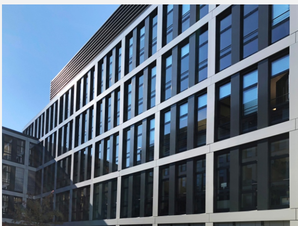
Foto 4: Innen montierte Folienrollos sind wettergeschützt und wartungsfrei
